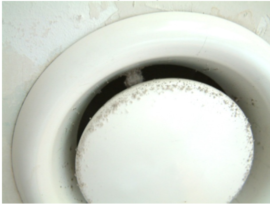
Bild 7: Staubablagerungen auf Abluftventilen
