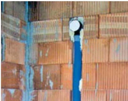
Bild 1: Ordnungsgemäß verschlossene Luftleitung in der Bauphase (Quelle: Wernig)
